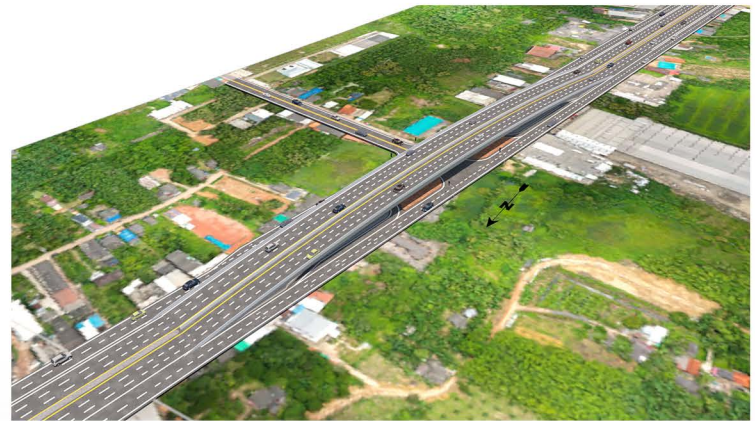
สะพานข้ามแยกป้อมพะเนียด
