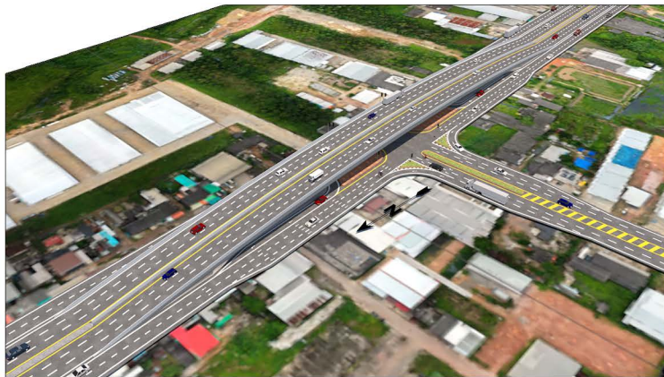
สะพานข้ามแยกวังตะกอบ
