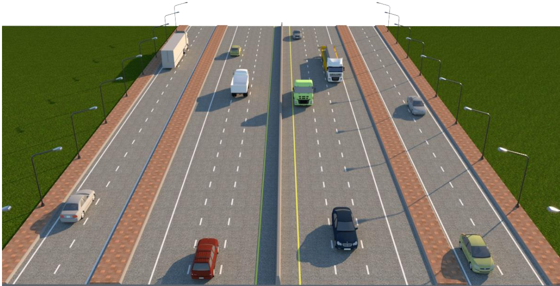
รูปที่ 6-5 ทางเลือกที่เหมาะสมกับพื้นที่โครงการ ทางหลวงขนาด 10 ช่องจราจร แบ่งทิศทางการจราจรด้วยเกาะกลางแบบกึ่งแบ่งคอนกรีต (Barrier Median)
