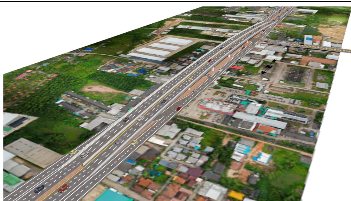
สะพานข้ามทางแยกวังตะกอกและยกระดับถึงโรงพยาบาลหลังสวน
