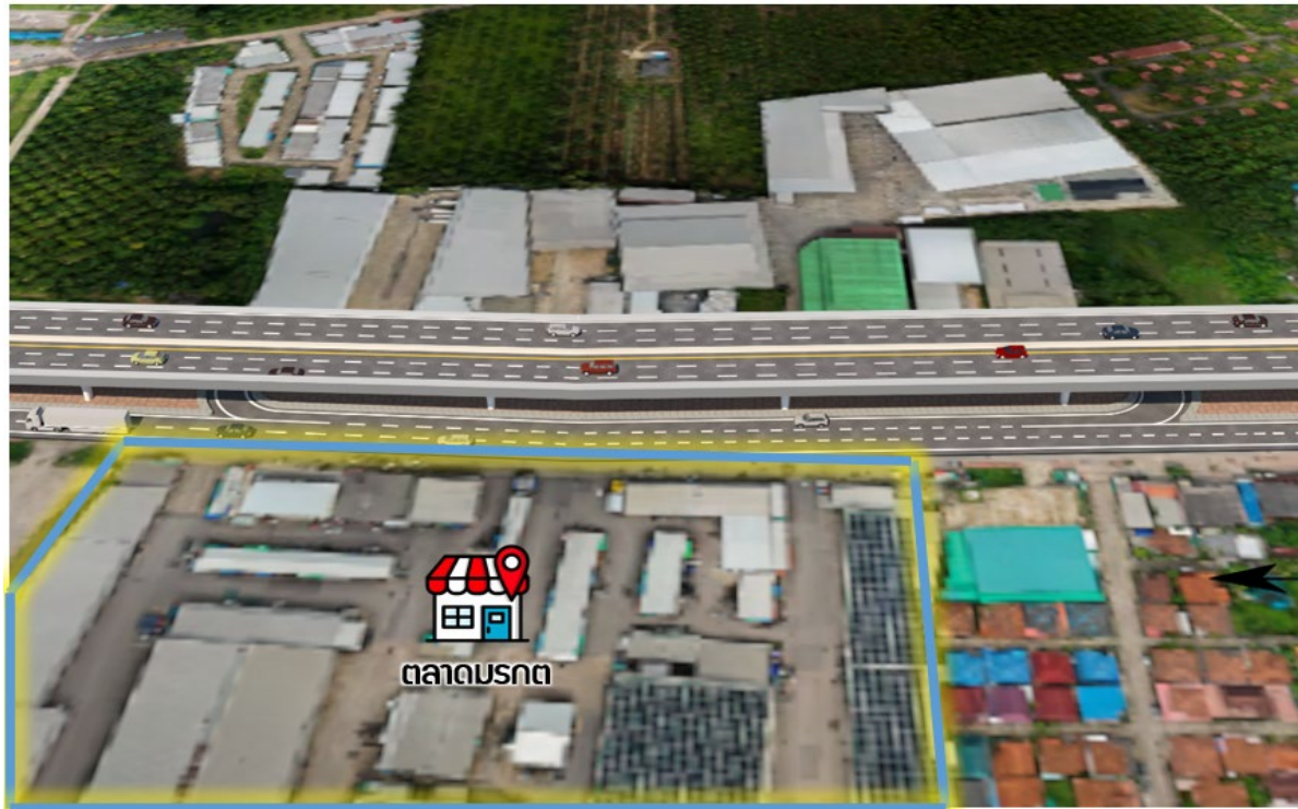
รูปที่ 6-8 จุดกลับรถใต้สะพานบริเวณตลาดมรกต
